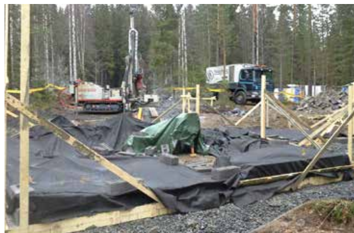
Sopiva ajoitus lämpökaivon poraukseen rakennustyömaalla.
