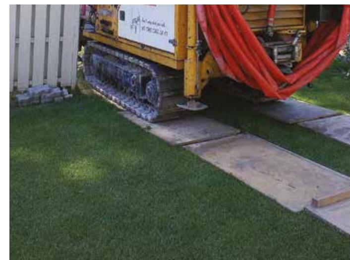
Poraus koneen telojen alla voidaan käyttää vanerisuojujauksia, jolloin jälkiä ei juuri jää nurmelle.
