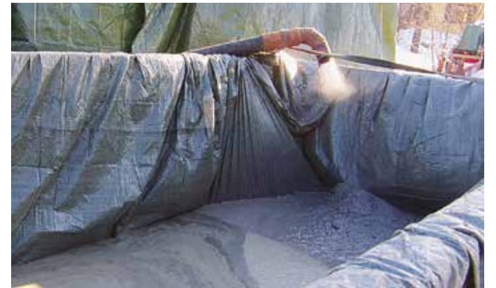
Kivituhkan purku lavalle. Kivituhka on porausvaiheessa savimaista.
