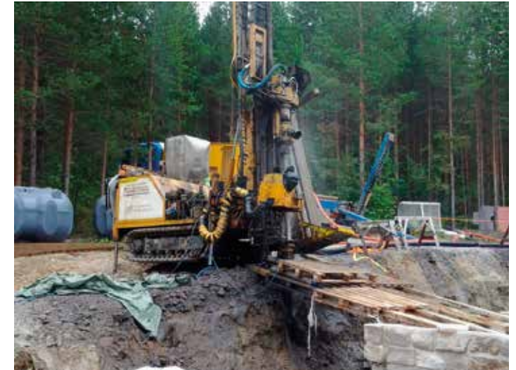
Virheellinen porauspaikan sijoittelu. Porari joutuu tekemään itselleen porauspaikan koneen eteen montun takia. Jos porauspaikalle kaivetaan monttua etukäteen, tulee kaivannon olla riittävän iso koko koneelle ja porarille.
