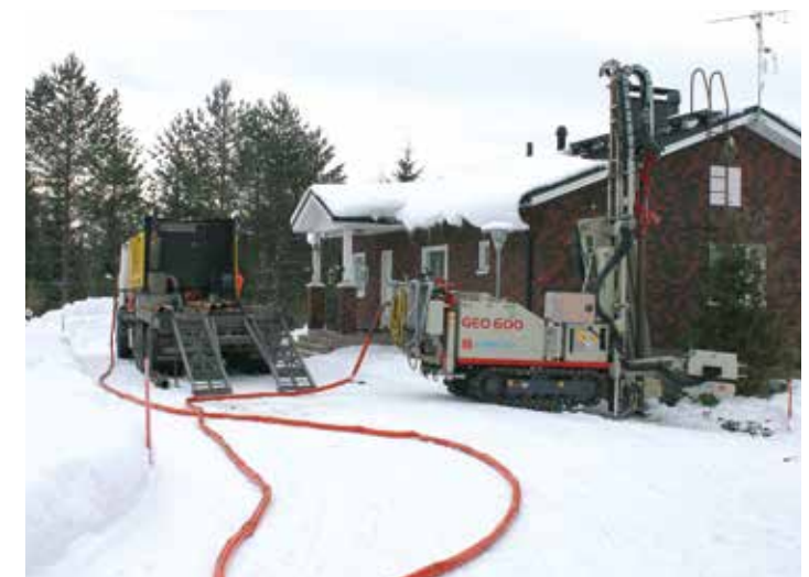
Porauksen pakkasraja talvella on -15 astetta. Talvella on estettävä lumien tippuminen katolta porauspaikalle.
