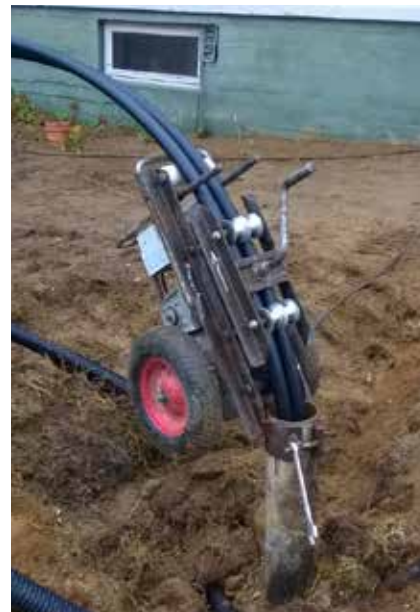
Lämmönkeruuputket (kollektori) lasketaan kaivon laskukoneen avulla, joka vaatii toimiakseen sähköä
