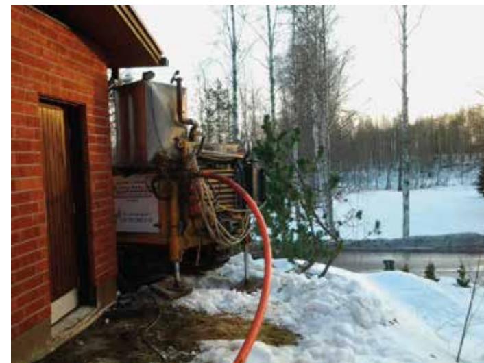
Liian ahdas porauspaikka. Huomioi riittävä korkeus ja leveys ajoreitillä. Ajoleveyttä on varattava koneelle n. 2,5 m, koneessa on 6m puomisto vaakatasossa, puustot tulee olla raivattu ajoreitiltä.
