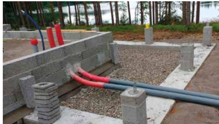
Oikein tehty läpivienti
