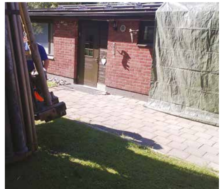
Rakennus on suojattu pressuilla.
