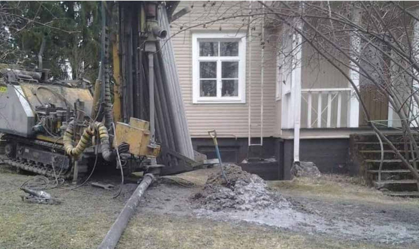
Pitkän maaporauksen porausjäte lapioitu kasaan
