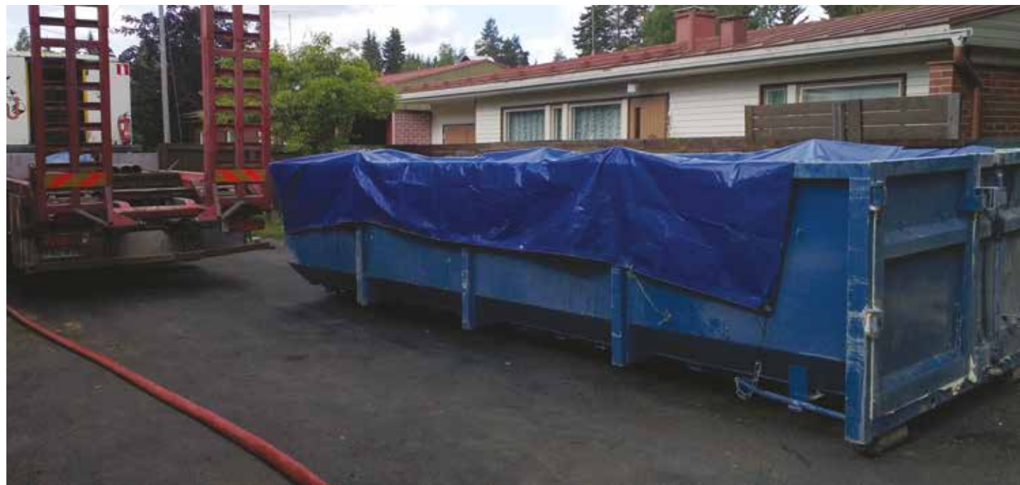
Vaihtolava on suojattu pressulla, jotta kivituhkapöly ja vesisumu ei leviä naapurin tontille. Huomioi myös riittävä kokoluokka lavalle (5500mmx2500mmx1200mm). Matalareunaiset rahtilavat eivät käy kivituhkan purkuun. Mikäli purku tehdään matalareunaiseen rahtilavaan, porausyrittäjä ei vastaa mitään osin pihan siivouksista ylilaitojen yli tulleista porausaineksista ja vesimassoista.
