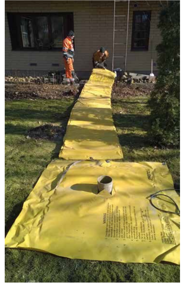
Routamatto. Talviporauksissa sähköä menee myös routamattojen käyttöön, jolloin kuluista vastaa asiakas.
