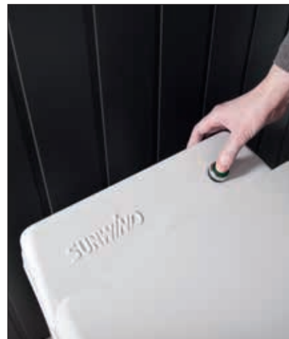
Trykk på knappen for å igangsette forbrenningen.
